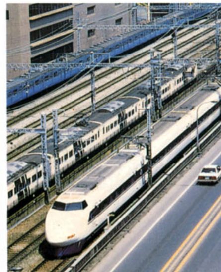
S60.~ JR新幹線(高架橋床版・防音壁)
