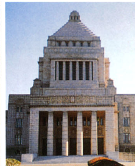
S62. 国会議事堂(尖塔部)
