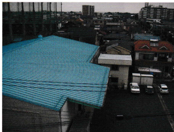
屋根塗装箇所
